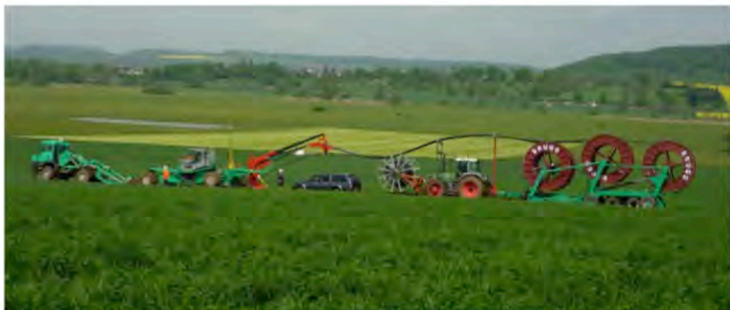
Verlegetrupp mit Seilwinden-Zugmaschine, Kabelpflug und Schlepper mit Kabelhänger Foto: ovag/Netz AG
