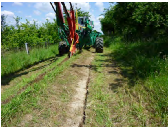
Pflugfurche mit bereits verlegtem Kabel Foto: ovag Netz AG
